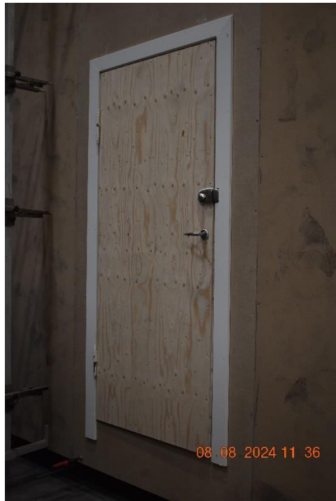
Foto nr. 23 Gerigter monteret over fugerne mellem karm og væg.
