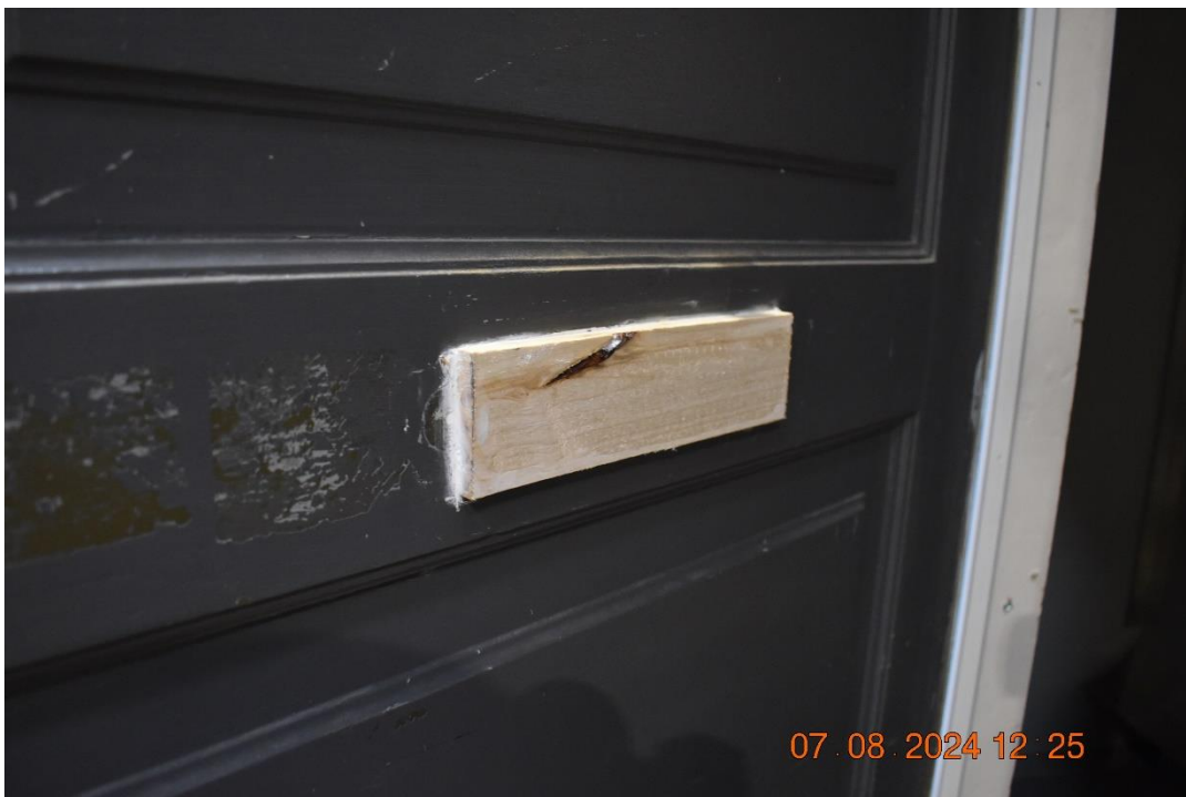
Foto nr. 10 Tætning af hul for brevsprække med træklods og fugemasse.
