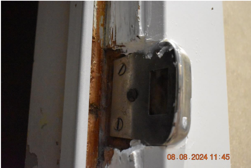
Foto nr. 25 Ekstra tætning med fugemasse omkring slutblik.
