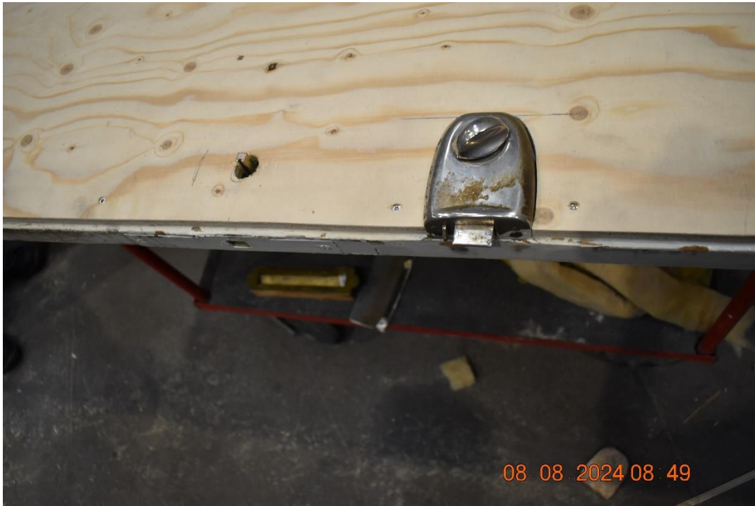
Foto nr. 17 Dørplade med påmonteret krydsfinerplade. Låsebeslag tilpasset.
