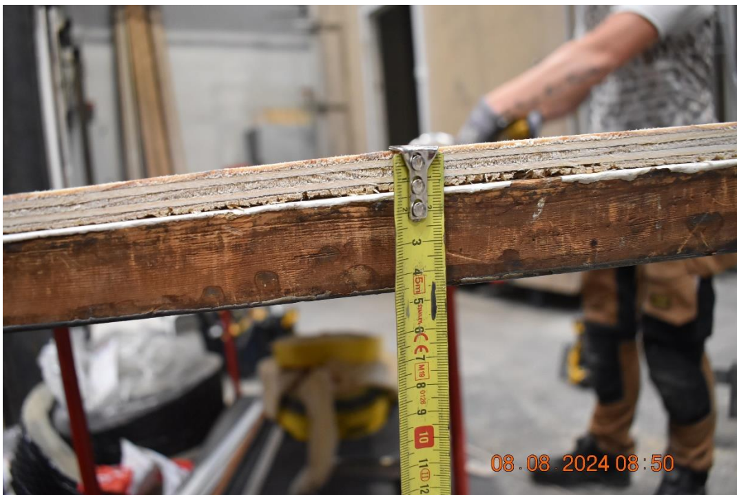
Foto nr. 18 Dørplade med påmonteret krydsfinerplade. Montage med trælim.
