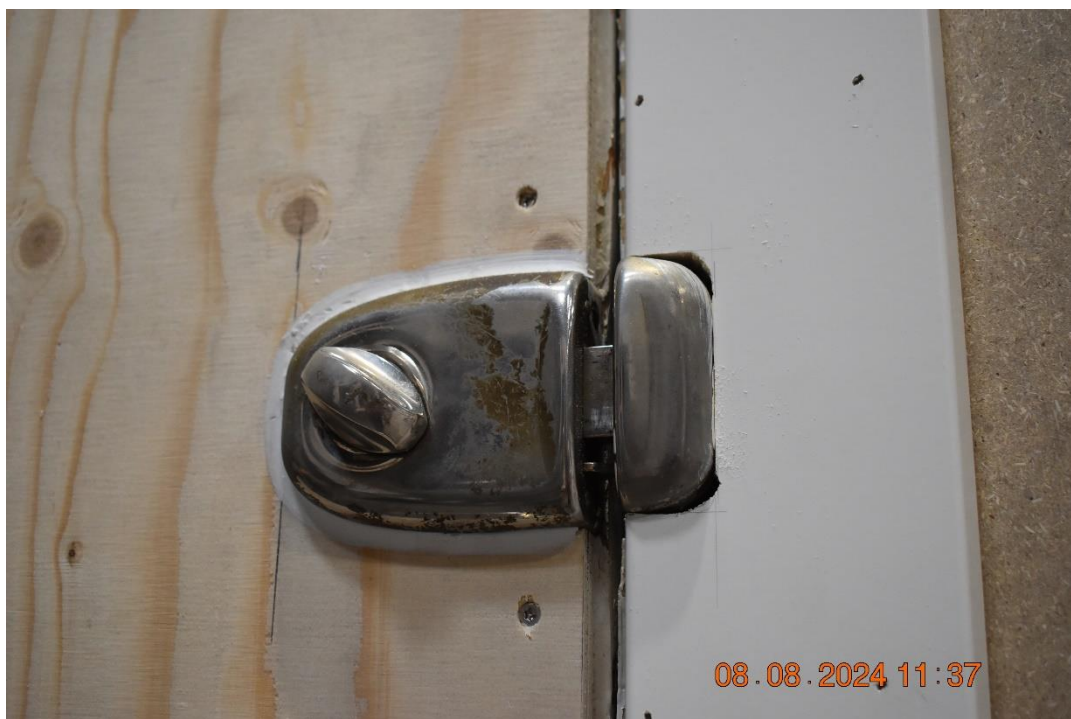
Foto nr. 24 Tilpasning og tætning omkring lås og slutblik.
