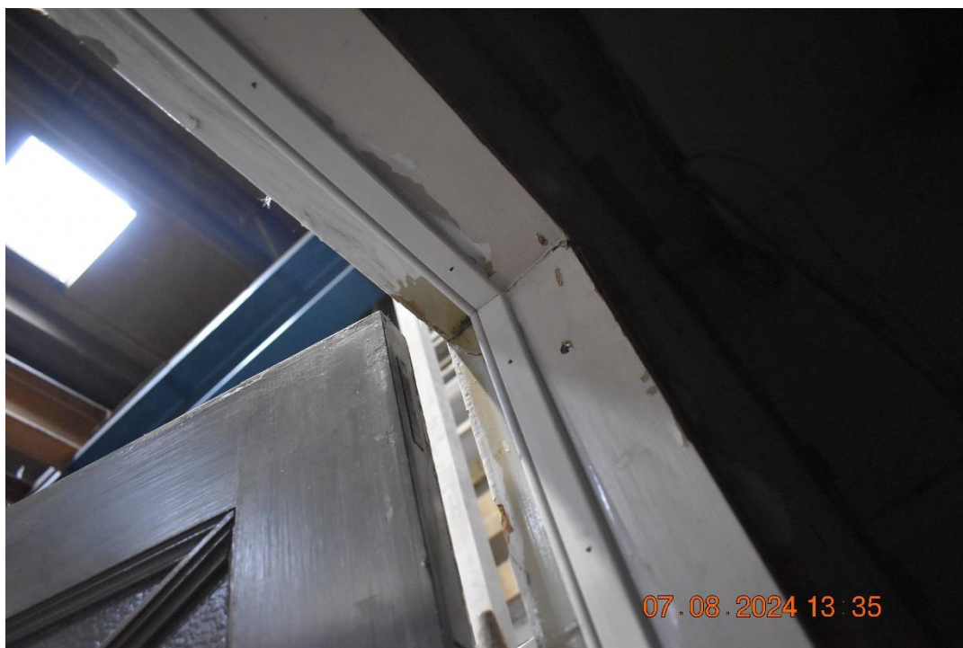
Foto nr. 14 Ekstra fugemasse tilføjet langs med den nye tætningsliste.
