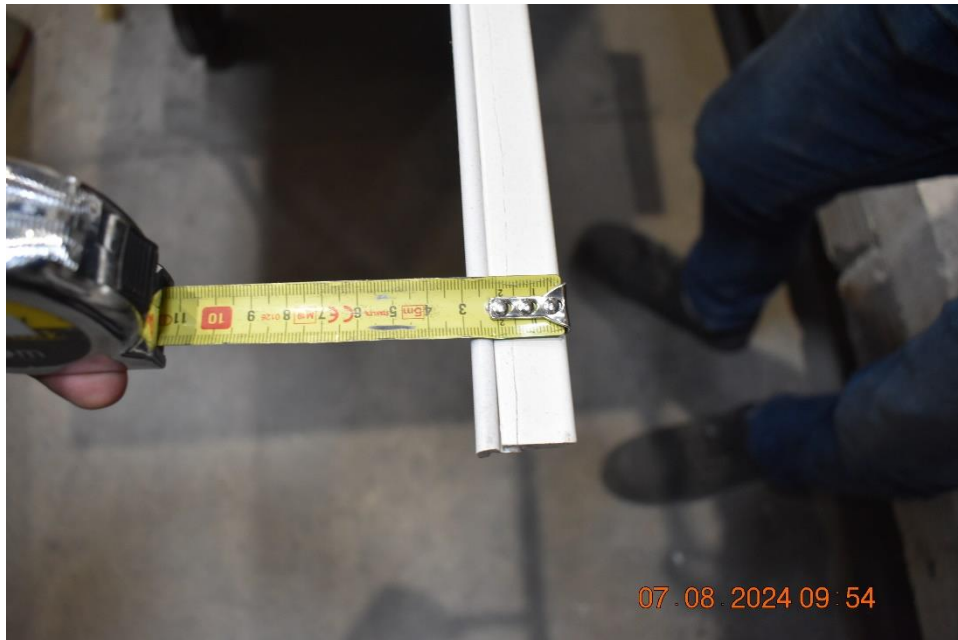
Foto nr. 7 Ny tætningsliste, kombination af træliste med skumtætning.
