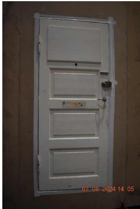
Foto nr. 15 Tape over fugerne mellem karm og væg, inklusiv langs underkanten af bundstykket.
