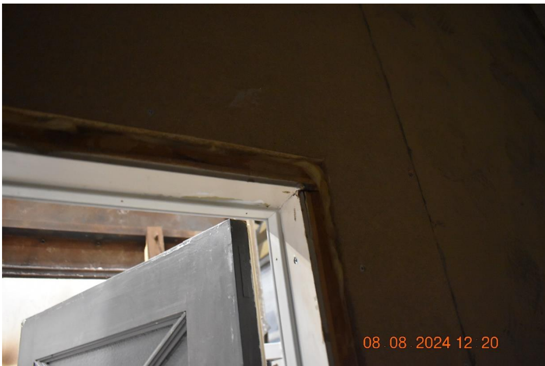
Foto nr. 26 Stopning med glasuld i fugerne mellem dørkarm og væg fra dørens lukkeside.
