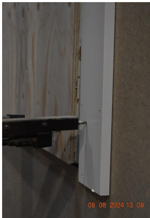
Foto nr. 28 Udbøjning i dørpladens nederste hjørne i låsesiden, under den varme test.
