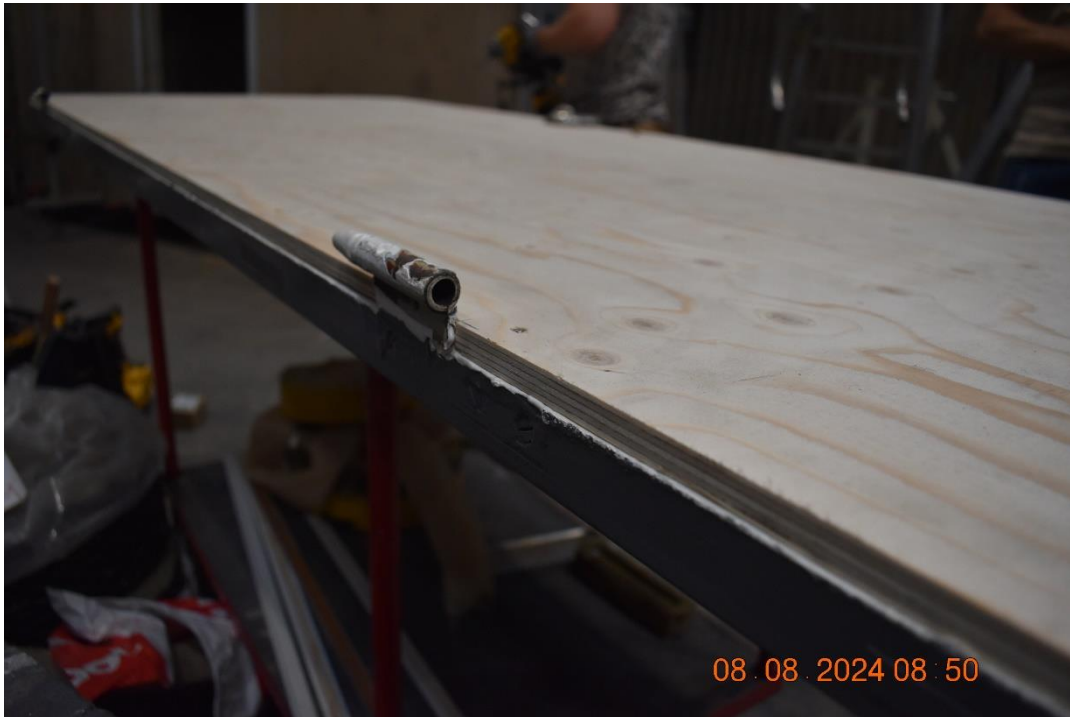
Foto nr. 19 Dørplade med påmonteret krydsfinerplade. Hængsler justeret.
