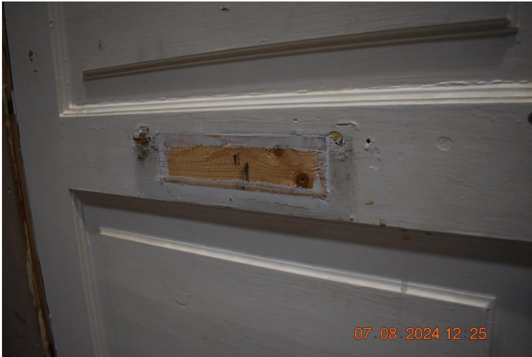
Foto nr. 9 Tætning af hul for brevsprække med træklods og fugemasse.
